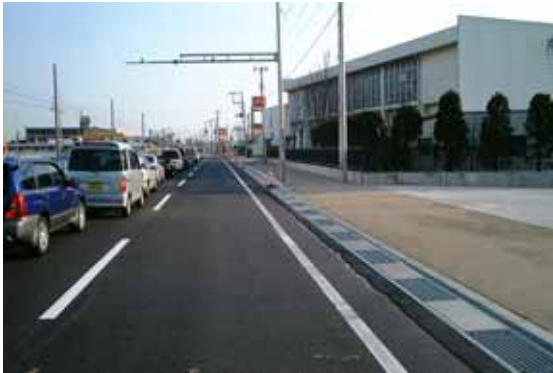
新潟小須戸線緊急地方道（街路）工事 平成16年3月竣工
