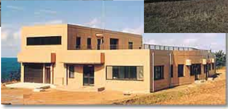
姫津漁港漁業集落環境整備排水処理（土木・建築）工事
