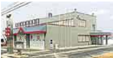
三条地域消防署下田分署建設工事
