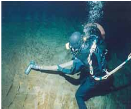
ダイバー清掃工法
