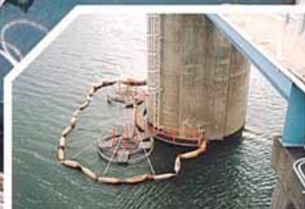
取水塔円形スクリーン修繕後
