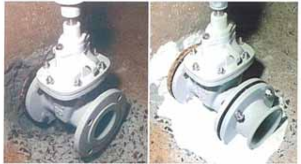
バルブ交換作業後
