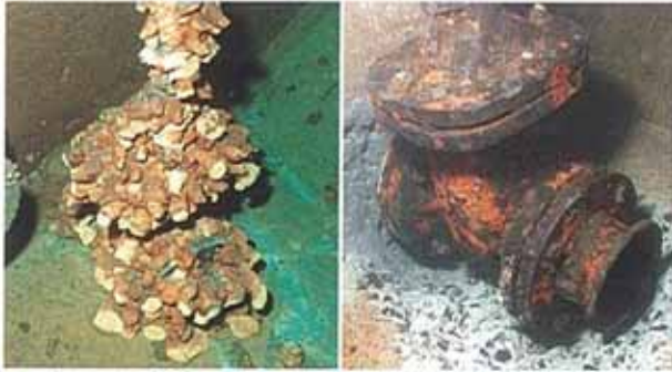
バルブ交換作業前
