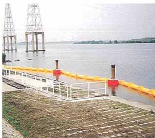
取水口オイルフェンス取付
