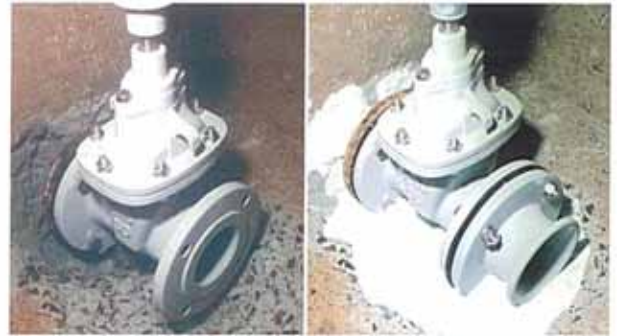
バルブ交換作業後
