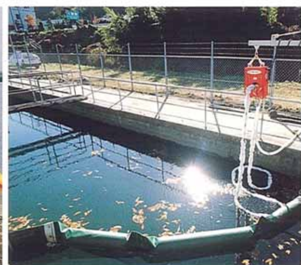
取水口オイルモッパー取付
